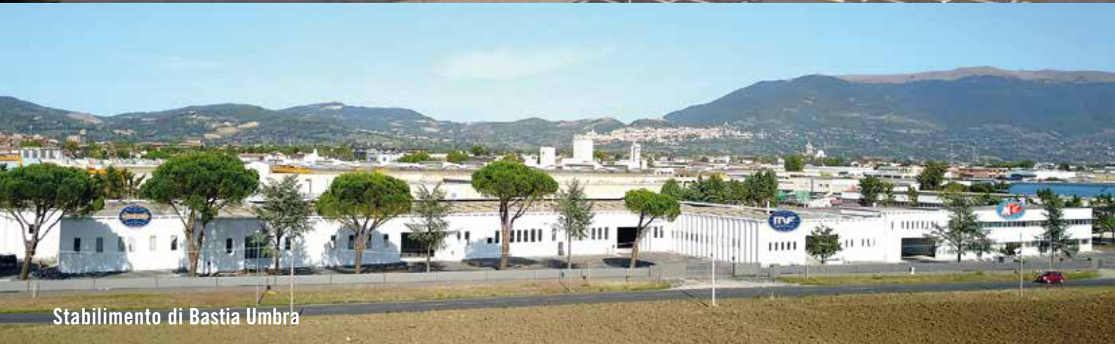
Stabilimento di Tordandrea di Assisi
